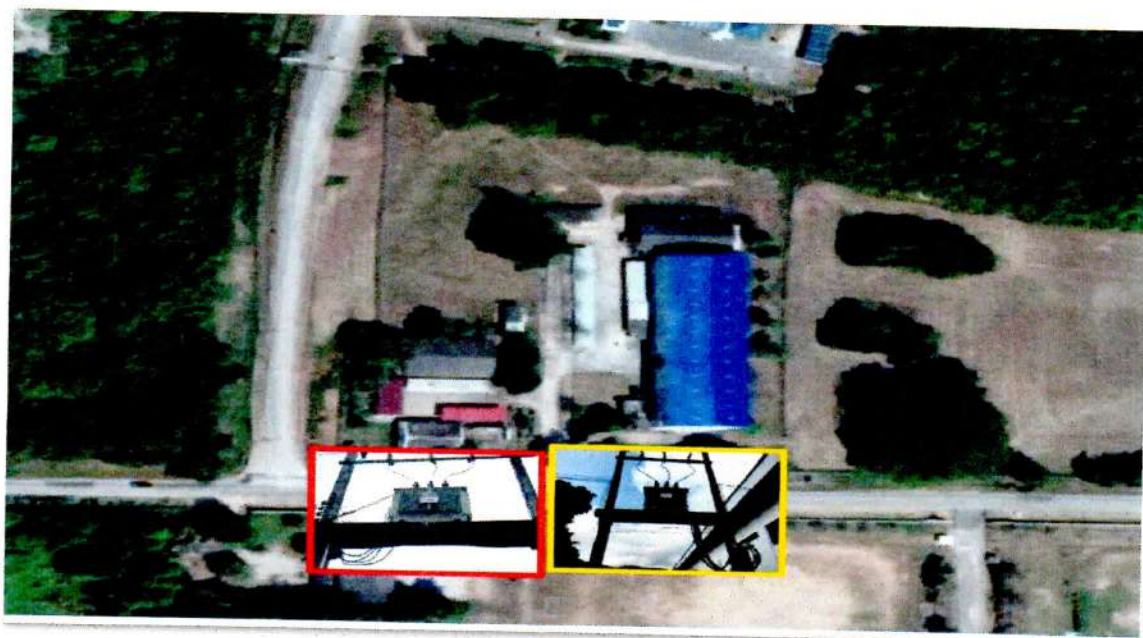
รูปที่ ๔๑ ตำแหน่งที่ติดตั้งหม้อแปลงไฟฟ้าขนาด ๓๑๕, ๕๐๐ KVA ข้างโรงสูบน้ำต้นสน และข้างโรงงานซ่อมบำรุงปืน ๓๗ มม. กทว.ศชส.สพ.ทร.
