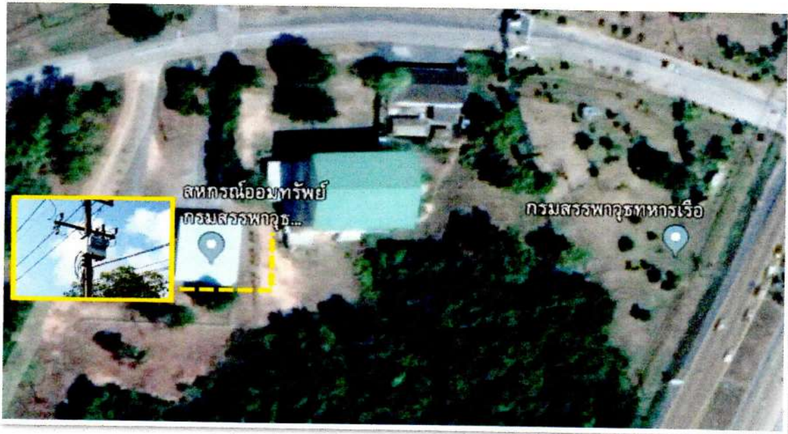
รูปที่ ๒๐ ตำแหน่งที่ติดตั้งหม้อแปลงไฟฟ้าขนาด ๓๗.๕ KVA. ข้างอาคารสหกรณ์ออมทรัพย์ สพ.ทร.
