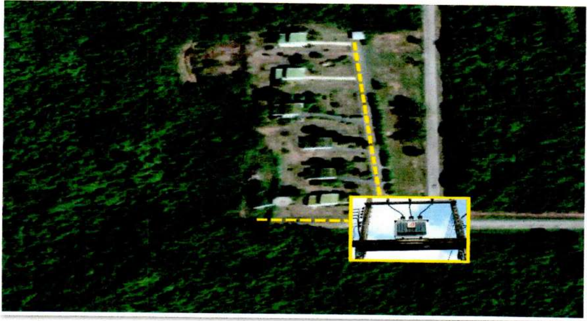
รูปที่ ๒๕ ตำแหน่งที่ติดตั้งหม้อแปลงไฟฟ้าขนาด ๒๕๐ KVA. บ้านพักรับรองผู้บังคับบัญชา สพ.ทร.
