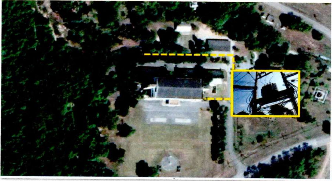
รูปที่ ๑๖ ตำแหน่งที่ติดตั้งหม้อแปลงไฟฟ้าขนาด ๕๐๐ KVA. ข้างอาคาร บก.สพ.ทร.
