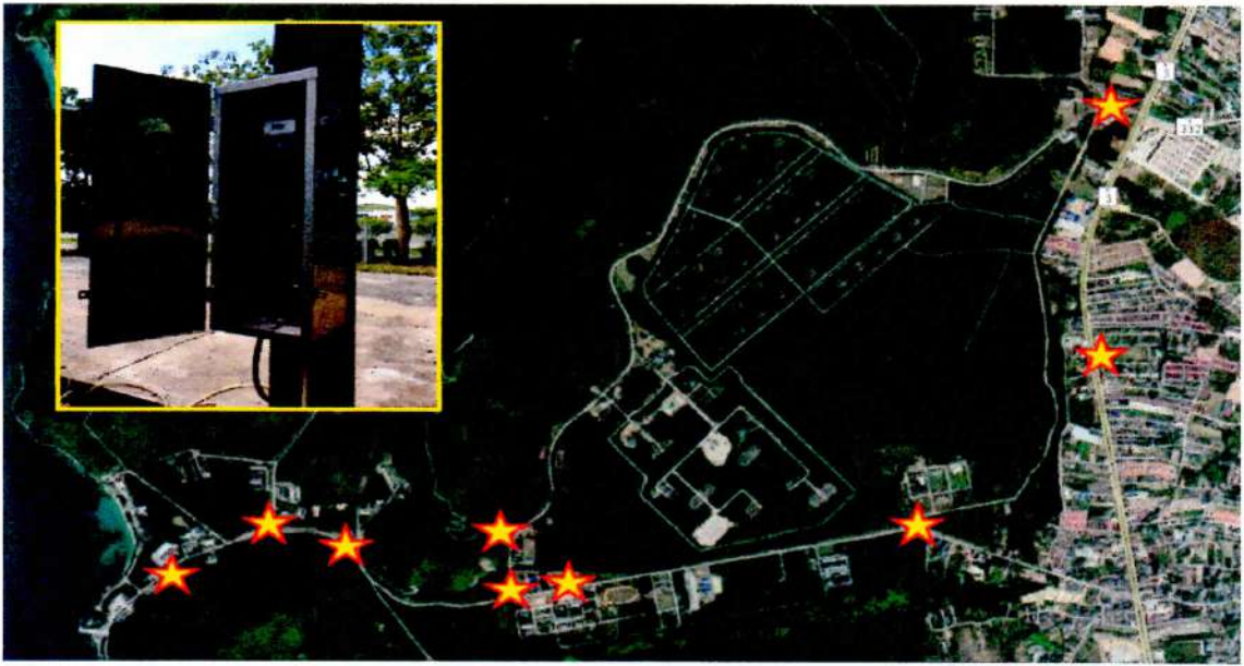
รูปที่ ๑๓ ตำแหน่งที่ติดตั้งมาตรวัดไฟฟ้าแรงสูง
