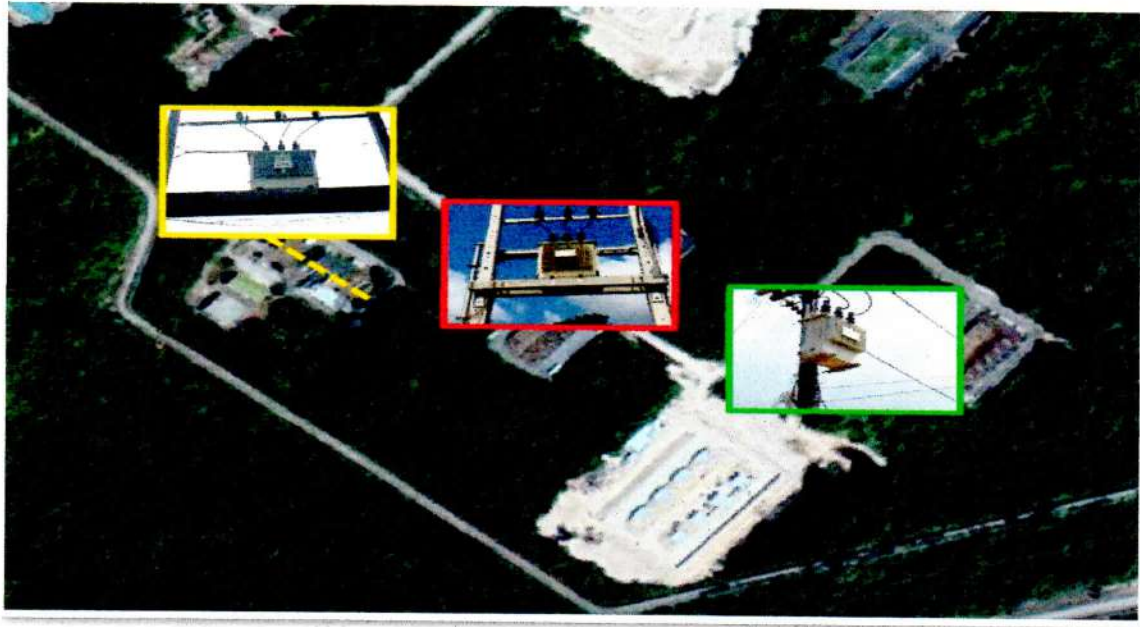
รูปที่ ๓๖ ตำแหน่งที่ติดตั้งหม้อแปลงไฟฟ้าขนาด ๑๐๐, ๓๑๕ KVA.
