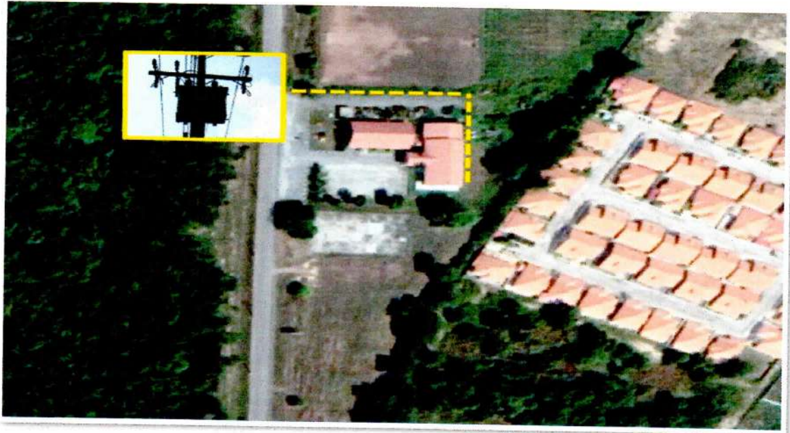
รูปที่ ๒๒ ตำแหน่งที่ติดตั้งหม้อแปลงไฟฟ้าขนาด ๑๖๐ KVA. หน้าสโมสรสัญญาณ
