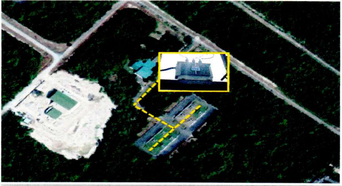
รูปที่ ๓๔ ตำแหน่งที่ติดตั้งหม้อแปลงไฟฟ้าขนาด ๕๐๐ KVA. ข้างอาคารทดสอบพื้นสู่พื้น ๓ กอว.สพ.ทร.
