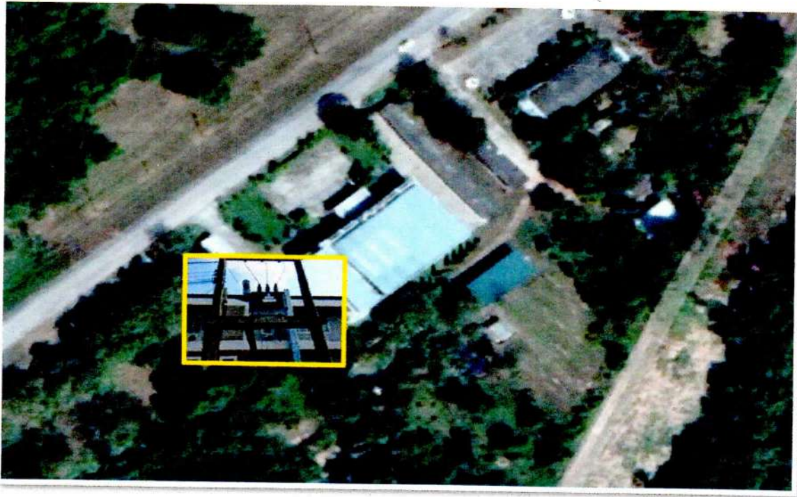
รูปที่ ๑๘ ตำแหน่งที่ติดตั้งหม้อแปลงไฟฟ้าขนาด ๓๑๕ KVA. ช้างอาคาร บก.กวก.สพ.ทร.
