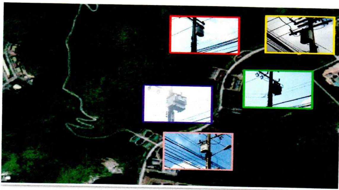
รูปที่ ๓๙ ตำแหน่งที่ติดตั้งหม้อแปลงไฟฟ้าขนาด ๕๐ KVA หน้าแผนกโยธา, หน้าค้ำ ๒๗๕ กอว.สพ.ทร., หน้าค้ำจรวดและเป้าลวง, หน้าค้ำอาวุธใต้น้ำ และ หน้ากลุ่มค้ำสรรพาวุธ ๔ ค้ำ
