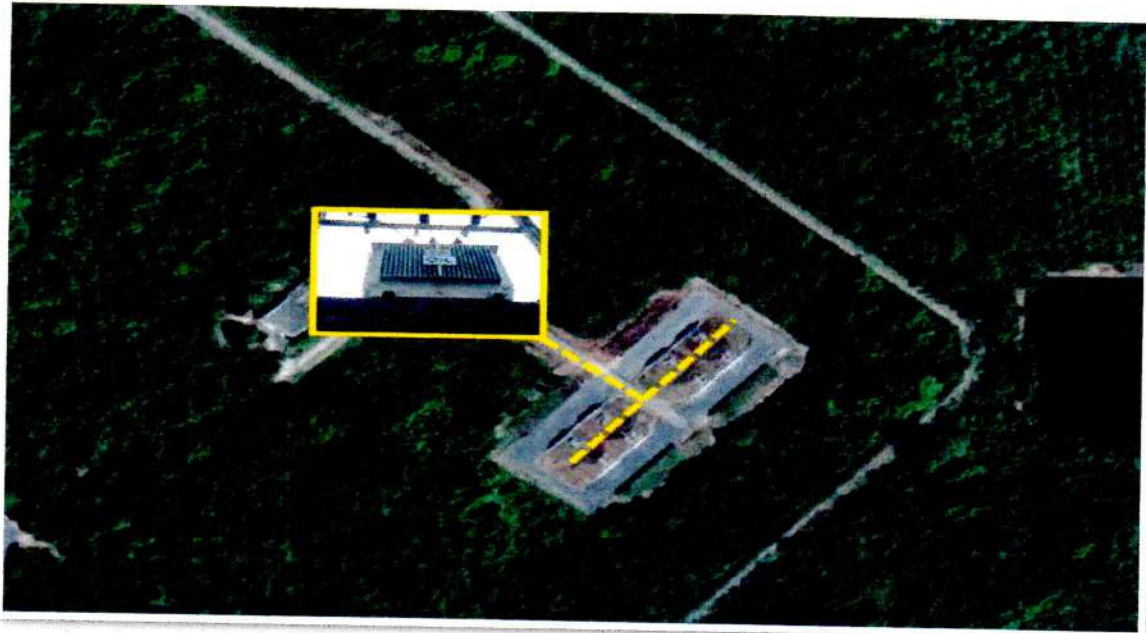
รูปที่ ๓๕ ตำแหน่งที่ติดตั้งหม้อแปลงไฟฟ้าขนาด ๕๐๐ KVA. ข้างอาคารทดสอบพื้นสู่อากาศ กอว.สพ.ทร.
