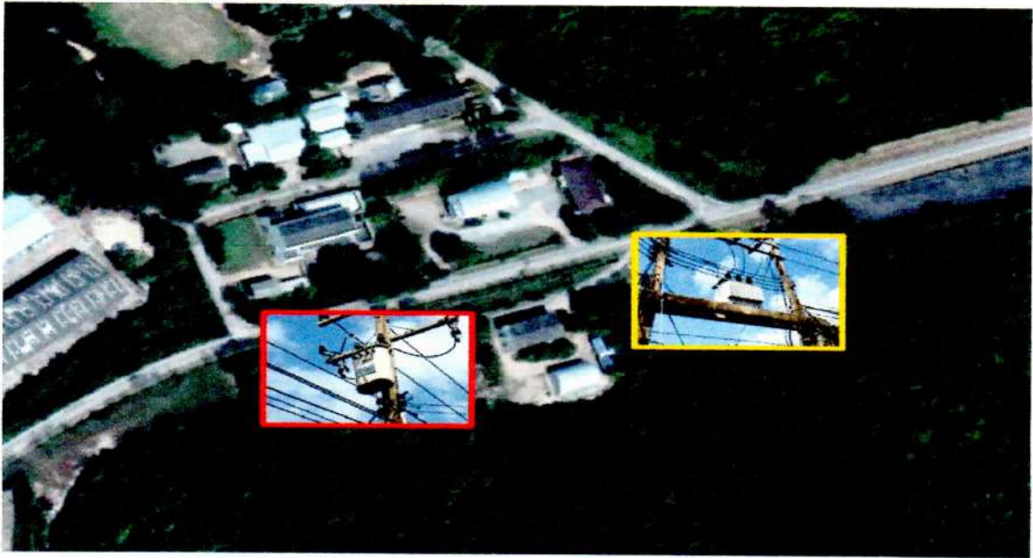
รูปที่ ๔๙ ตำแหน่งที่ติดตั้งหม้อแปลงไฟฟ้าขนาด ๕๐, ๒๕๐ KVA แผนกทัศนทัศน์ กทว.ศชส.สพ.ทร.
