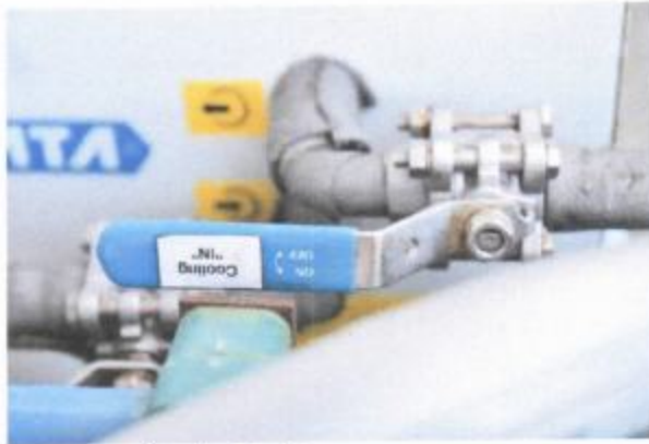
Valve น้ำหล่อเย็นเข้า
